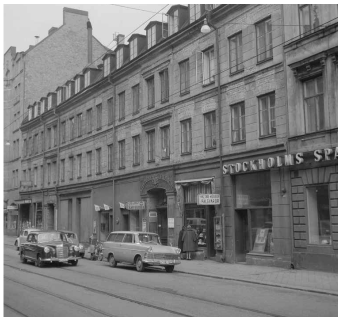
Sibyllegatan 10–12 inför rivning 1961. Foto Margareta Cramér.
